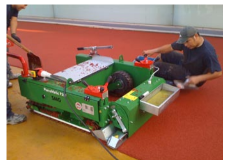
Einbau mit Spezialmaschine Bild: SMG
