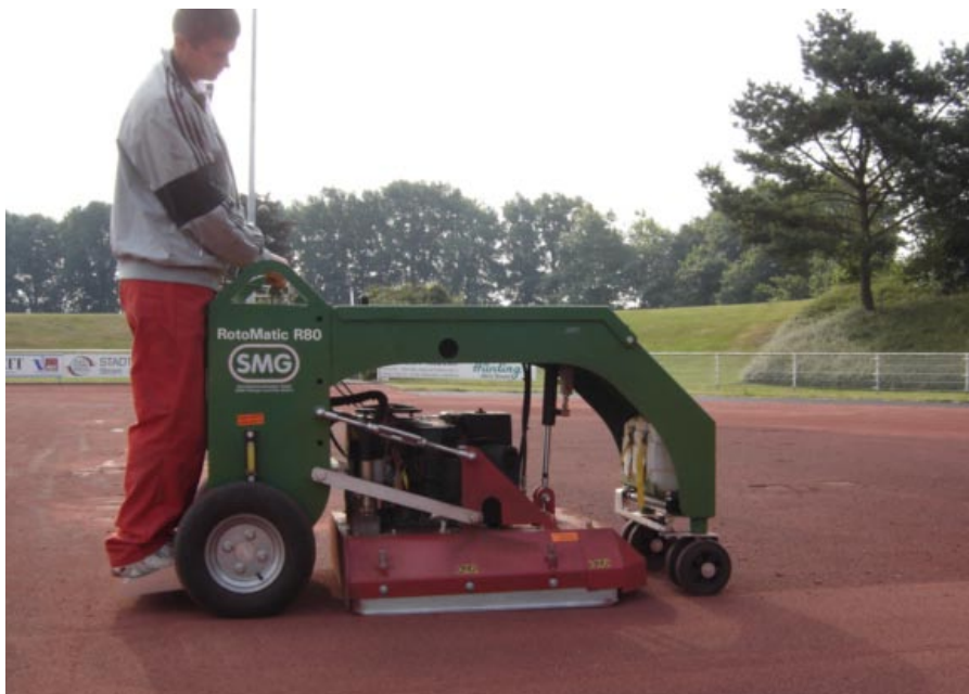
Bei einer vernachlässigten Bahn hilft nur das Abschleifen und dann das Retopping
