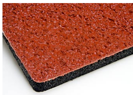
Spritzbeschichtung, z.B. bei der Sanierung verwendet
