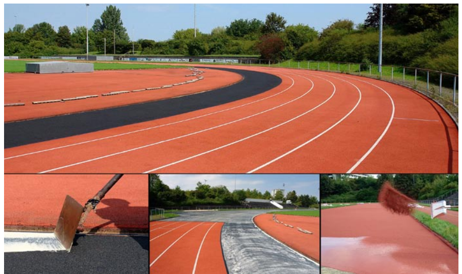
Die Innenbahn wird am meisten genutzt und verschleißt zuerst. Es empfiehlt sich eine Sanierung. Bild: Porplastic
