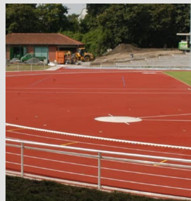
Nachher: Dieselbe Anlage nach dem Umbau, jetzt mit Kunststofflaufbahn Bild: STRABAG Sportstättenbau GmbH
