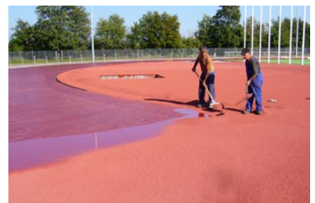
Auftrag des Granulats Bild: Gebr. Becker
