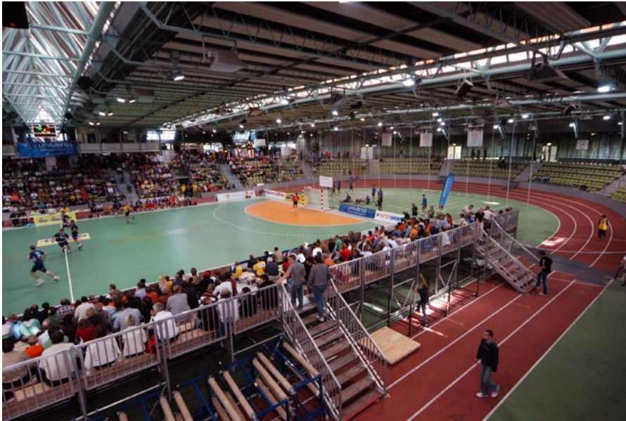
Mehrzwecktauglich: Fest installierte Laufbahn und temporäre Handball-Arena in einer Halle Bild: Stadionwelt
