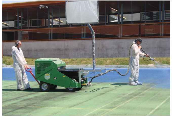
Normkonforme Neubeschichtung mit Strukturspritzmaschine
