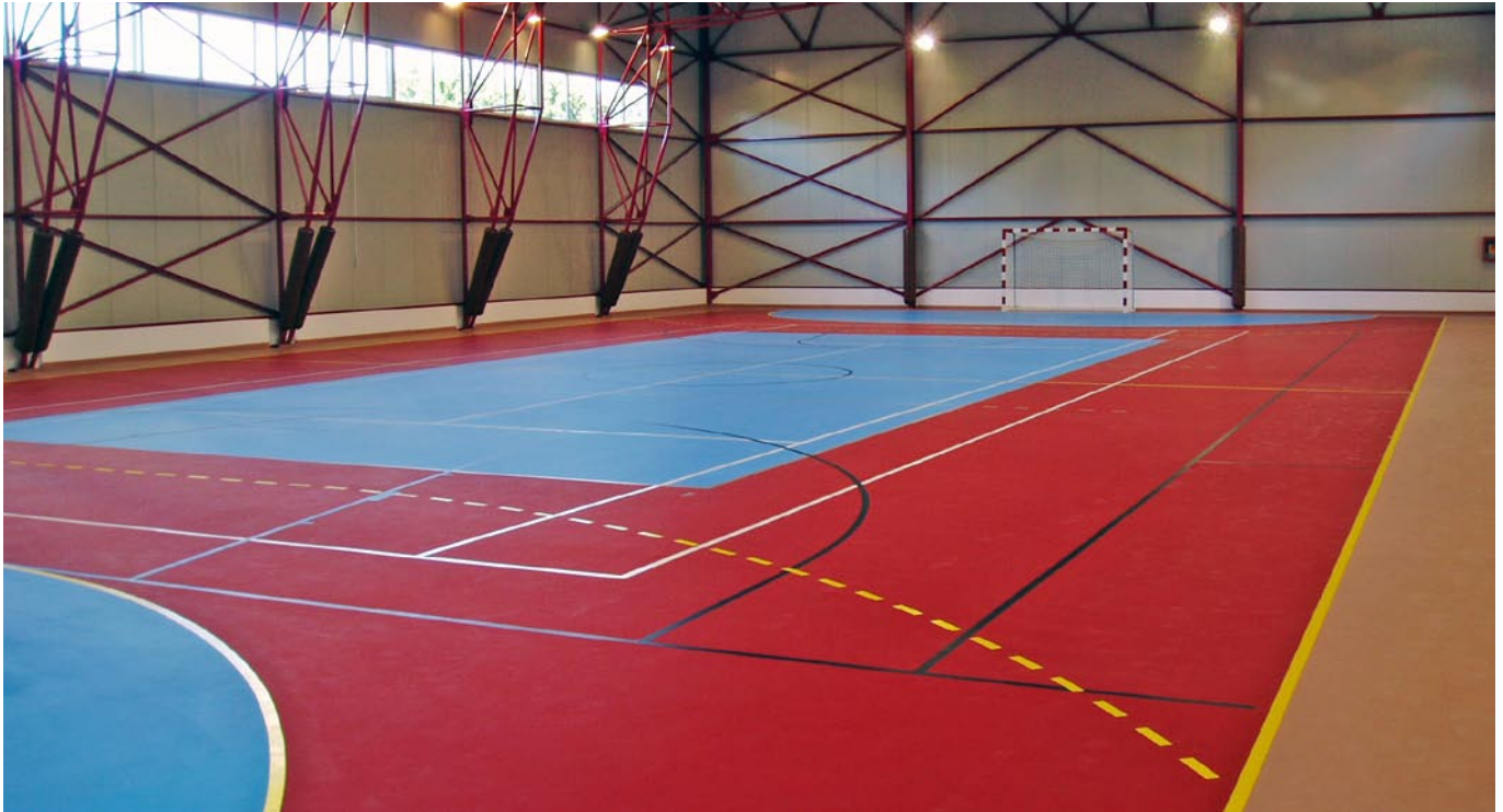
Eine Polyurethan-Nutzschicht wird flüssig aufgetragen und bildet dann einen fugenlosen Sportboden
