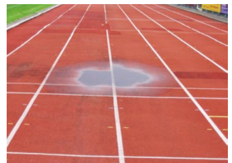
Eine Mulde – hier besteht Sanierungsbedarf
