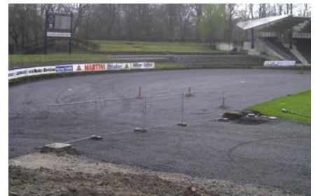
Der Asphalt wurde vorbereitet, jetzt kommt die Laufbahn Bild: Stadionwelt
